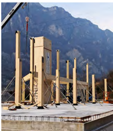
Struttura in legno
