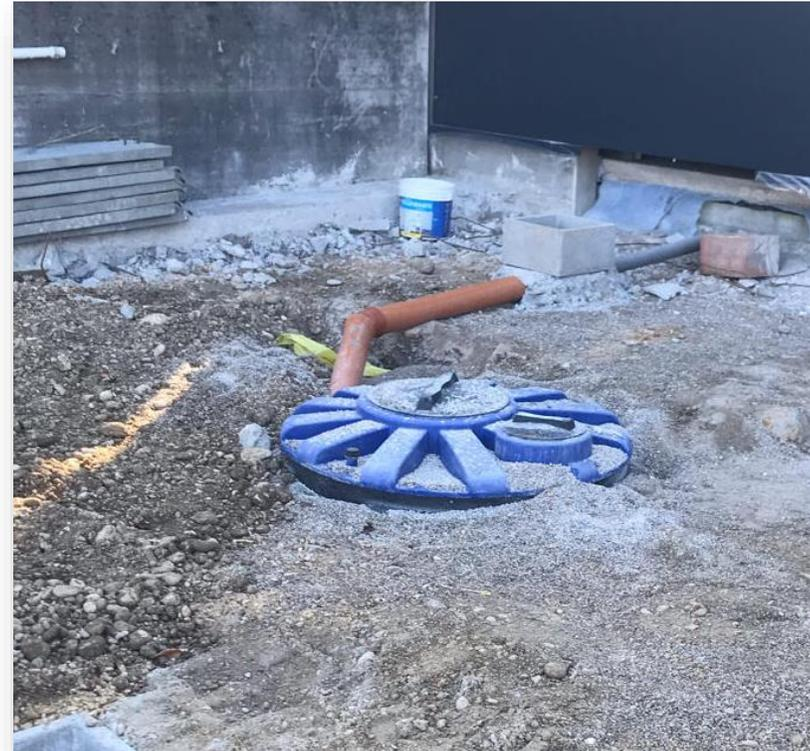
Impianto:      Degrassatore + Imhoff + filtro anaerobico + fanghi attivi
