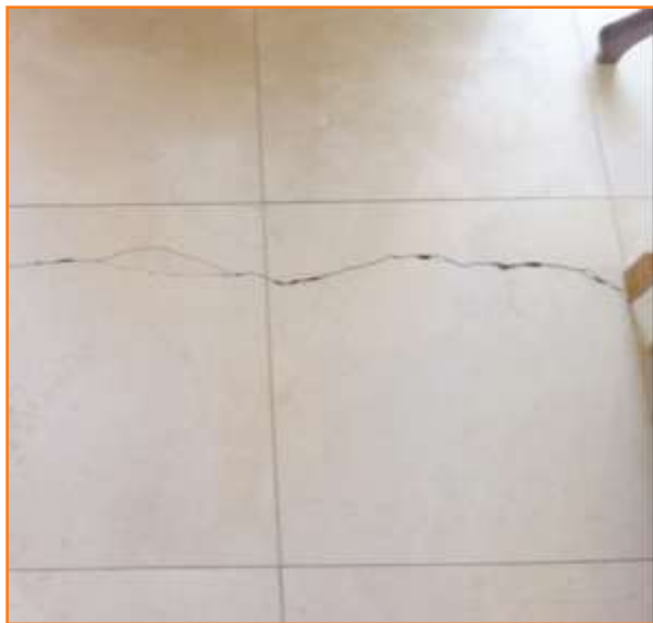
Rottura della piastrella
