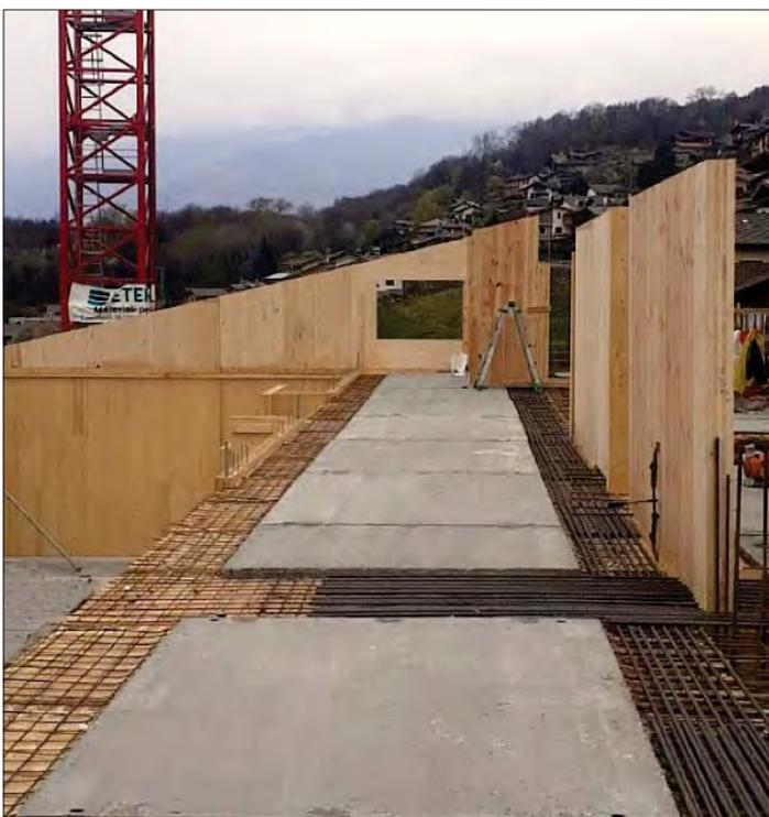
*Sopra: Il solaio Prepanel.*
