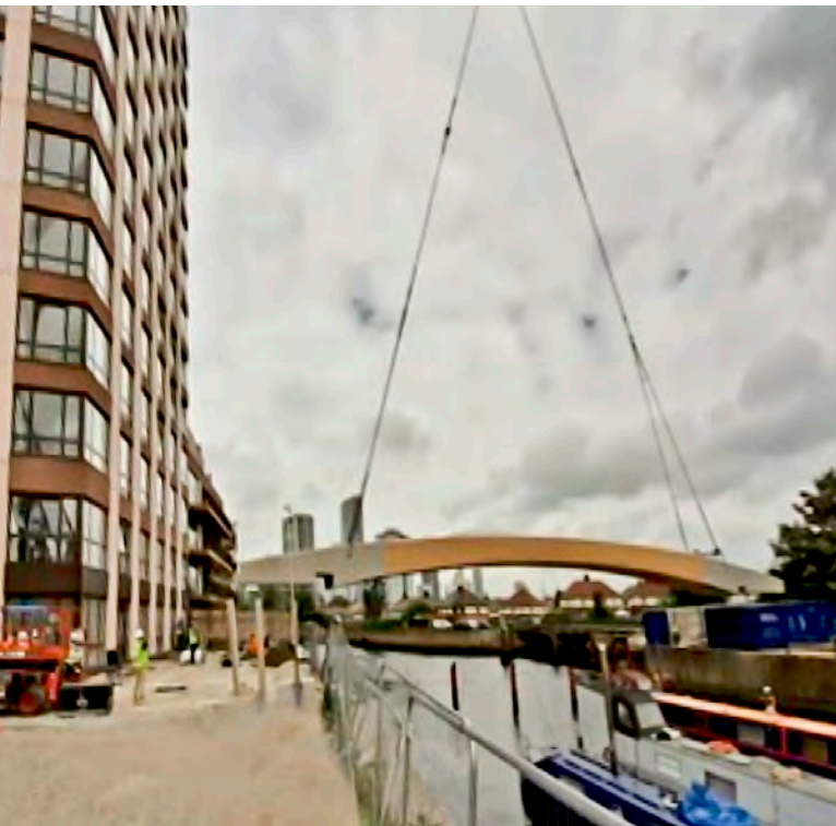
Montaggio del ponte in cantiere
