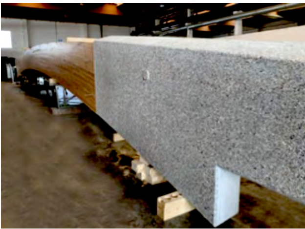
Prefabbricazione delle porzioni in calcestruzzo e delle travi in legno lamellare di larice
