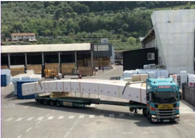
Trasporto del ponte prefabbricato
