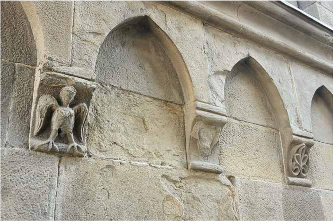
Le grandi trifore che caratterizzano tre facciate del Palazzo (Nord, Ovest, Sud) sono originali: ma alcune delle pietre che le compongono sono state sostituite nel corso dei moderni rifacimenti seguiti ai disastri della struttura. Le due finestre superiori della facciata Ovest sono state ricostruite seguendo i caratteri dei resti archeologici originali. Le merlature che decorano il tetto sono originali.
