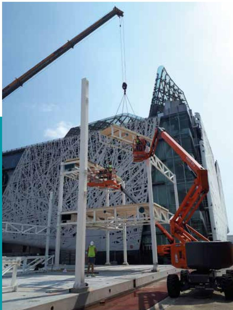
preassemblaggio in stabilimento dei solai che comprendono struttura, impianti e parte delle finiture. In corrispondenza dei corridoi centrali, sono stati predisposti elementi a cassone realizzati con reticolari in legno e acciaio: questa soluzione ha permesso di creare lo spazio necessario per la posa delle dorsali impiantistiche, mentre le travi reticolari hanno consentito di ottenere quello per gli attraversamenti impiantistici diretti verso i locali/laboratori.
