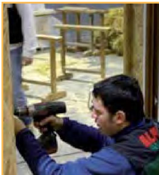
Il fissaggio del falso telaio sul laterizio avviene con viti.
