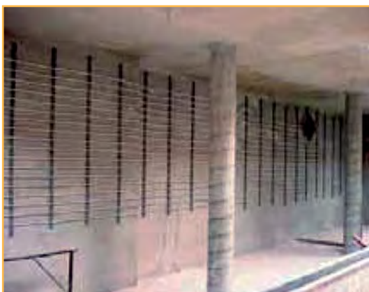
Realizzazione di un impianto a parete
