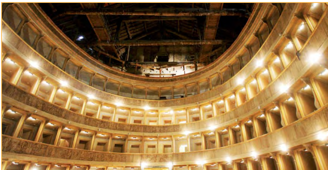
I Palchi e la copertura lignea durante i lavori.
