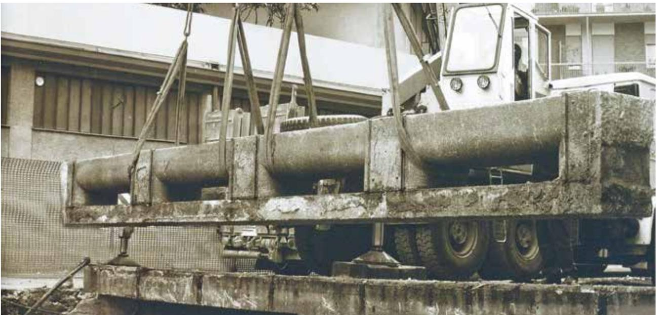
Particolarmente delicati i lavori di estrazione dei due monoliti (moduli di Plorzano e separatore della Roggia Nuova) dal letto del Serio Grande. Per realizzare questo spostamento in massima sicurezza hanno operato i tecnici di un'impresa altamente specializzata. Analoghe precauzioni sono state riservate alle lastre del letto della Roggia Serio, anch'esse recuperate e riutilizzate nella Fontana delle Rogge.
