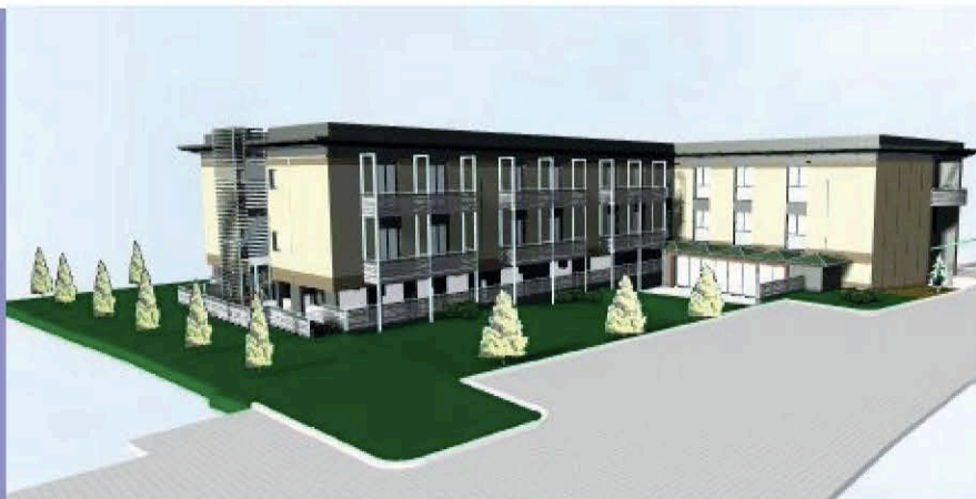
VISTA DA NORD
