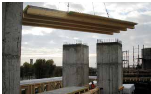
Montaggio del solaio Prepanel® e della parete ARIA®
