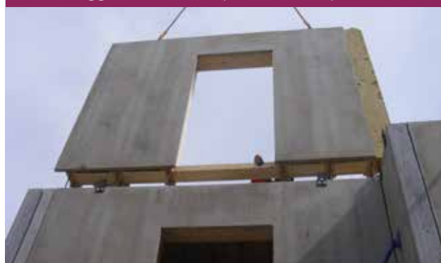
Montaggio del solaio Prepanel® e della parete ARIA®
